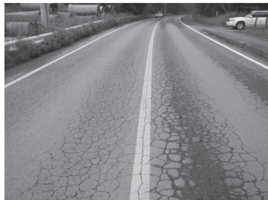
図14-5-3 (一) 蛭畑須佐木線 大田原市湯津上凍上災(平成24年2・3月低温)
