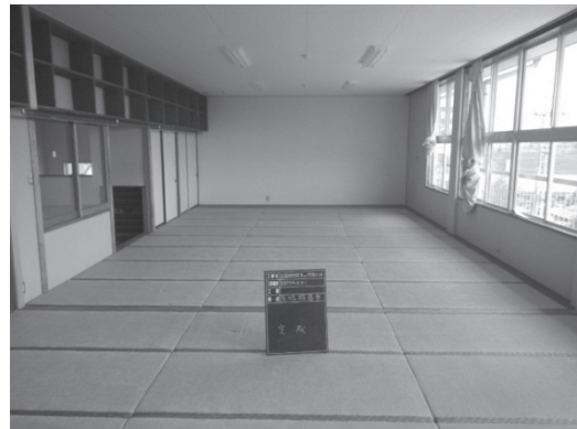
写真 14-3-15 復旧完了（平成24年8月）
