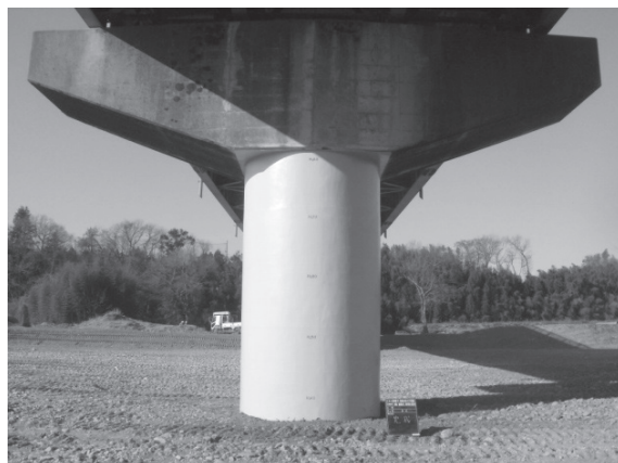
図14-3-6 復旧完了状況(平成24年3月)
