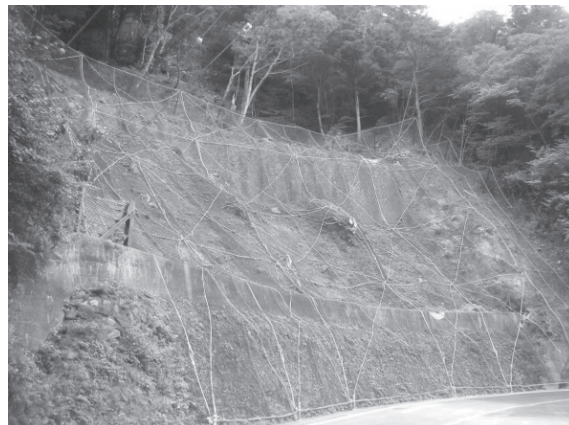
図14-3-4 復旧完了状況(平成23年12月)
