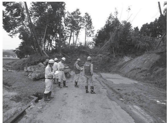
図 14-4-8 災害復旧技術専門家調査
