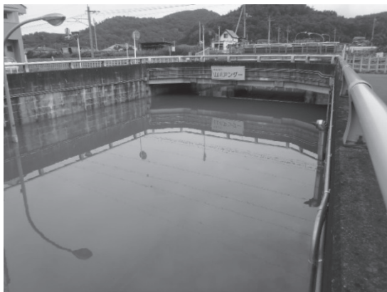
図14-5-2 (主) 足利環状線(足利市)山川アンダー冠水状況
