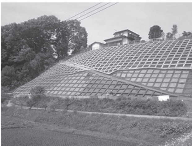
図 14-3-5 高根沢町 平和台地区(急傾斜地)
