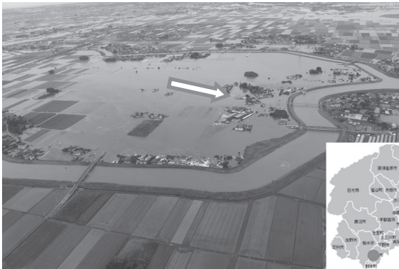
図 14-4-5 一級河川柚井木川（小山市押切）
