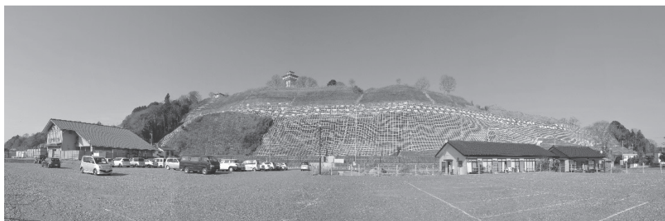
写真14-3-11 対策工完成（平成25年3月）
