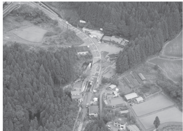
図 14-3-6 日光市 簗沢(土石流)
