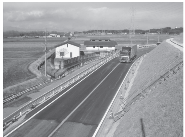
図 14-3-2 復旧完了状況(平成 23 年 12 月)
