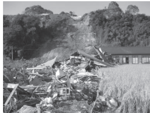
写真14-3-10 平成23年9月の台風による被災状況
