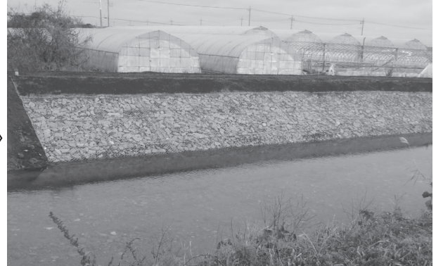
写真14-3-8 復旧完了（平成24年1月） かごマット工による復旧
