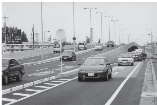
図9-1-11 宮環・鶴田陸橋
