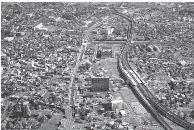
図9-1-21 栃木駅周辺連続立体交差 全景(栃木市)
