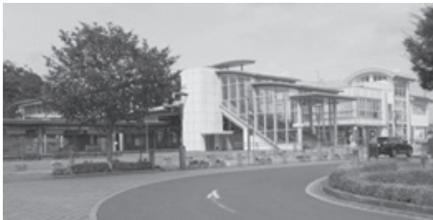
図 9-1-6 佐野駅自由通路・駅北口広場
