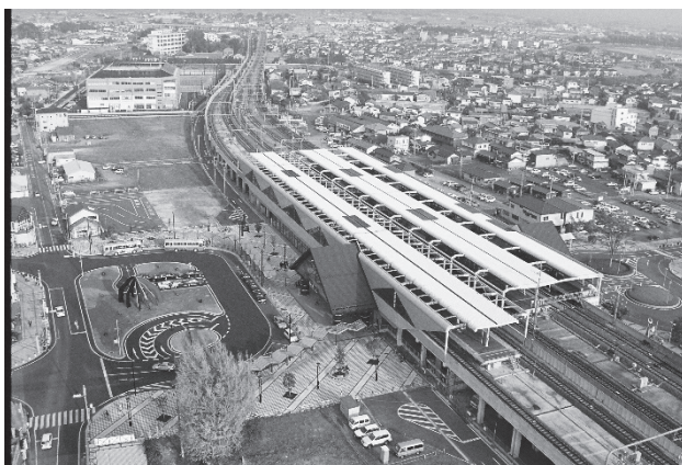
図9-1-22 栃木駅周辺連続立体交差 栃木駅(栃木市)
