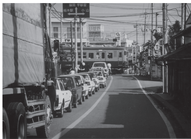
図 9-1-20 整備前の栃木駅周辺踏切
