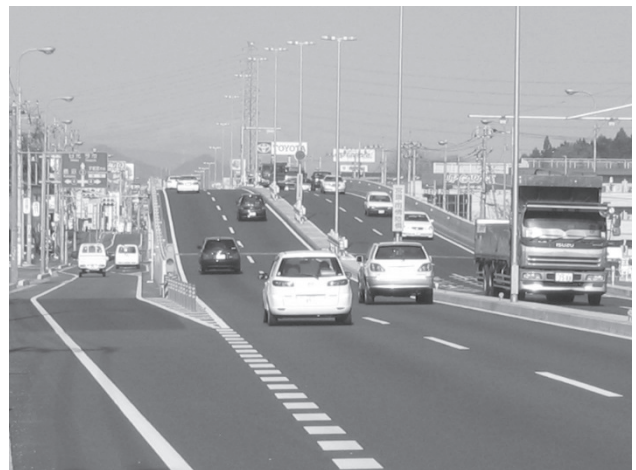
図9-1-13 宮環・雨情陸橋
