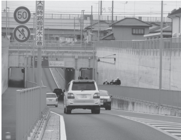
図9-1-26 間々田北通り (小山市：間々田アンダー)
