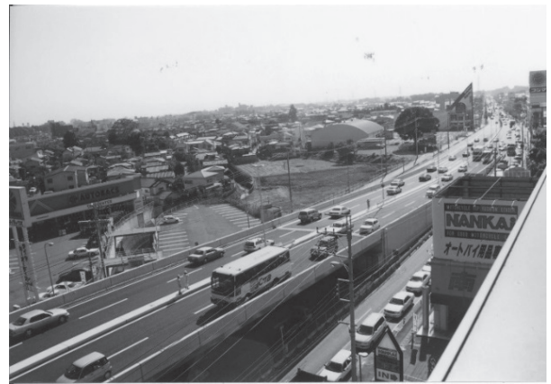
図9-1-12 宮環・駒生陸橋 2001
