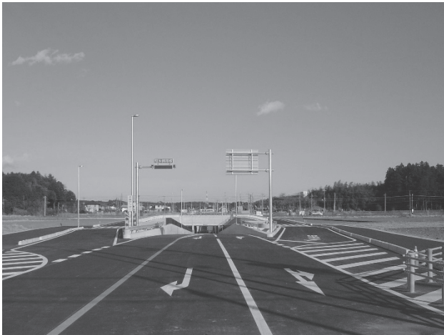
図 9-1-28 木幡通り（矢板市：木幡アンダー）
