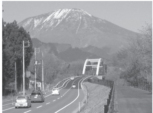
図9-1-18 瀬川森友線及び大谷川右岸線（日光市）
