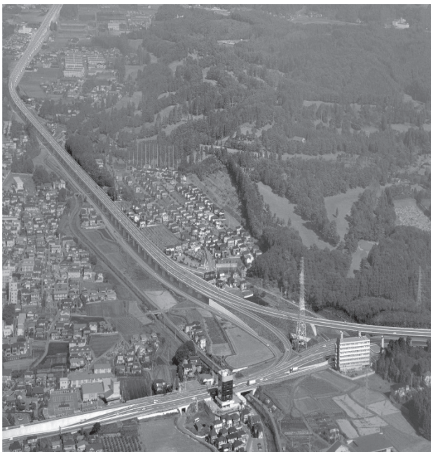
図 9-1-16 (国) 119 号交差部 (宇都宮北道路) インターチェンジ
