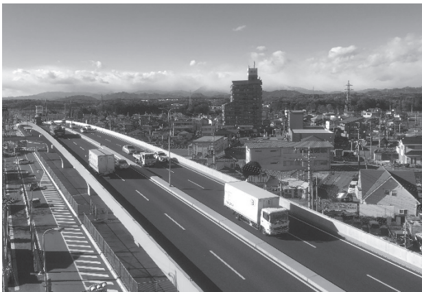
図 9-1-15 宮環・下川俣陸橋
