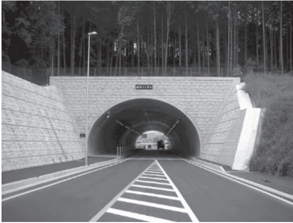
図2-6-69 稲沢トンネル 黒羽側坑口
