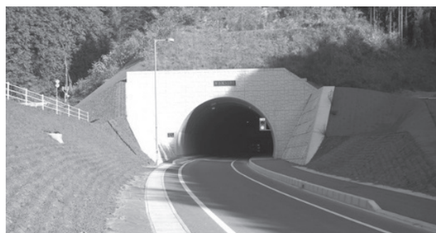
図 2-6-80 新会沢トンネル 佐野市側坑口
