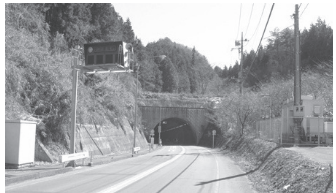
図2-6-60 鞍掛トンネル 日光側坑口
