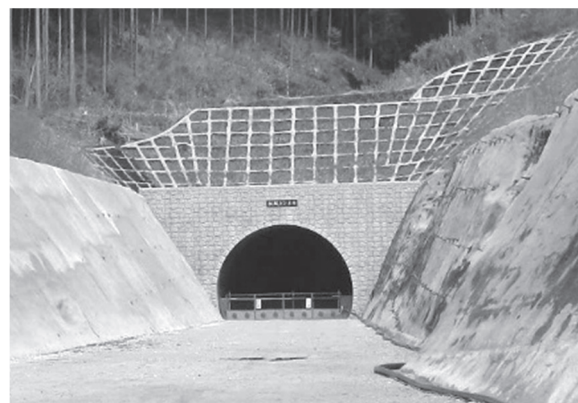
図2-6-62 松坂トンネル 引田側坑口
