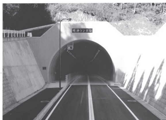
図2-6-74 明神トンネル 須賀川側坑口
