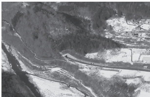
図2-6-68 愛宕山トンネル 川治側坑口と旧道
