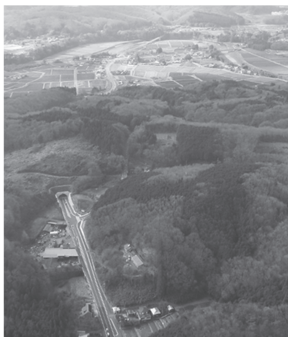
図 2-6-79 高瀬トンネル 那須烏山市側坑口
