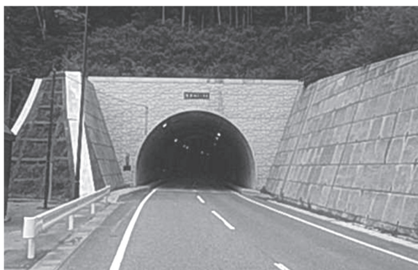
図2-6-67 愛宕山トンネル 川治側坑口
