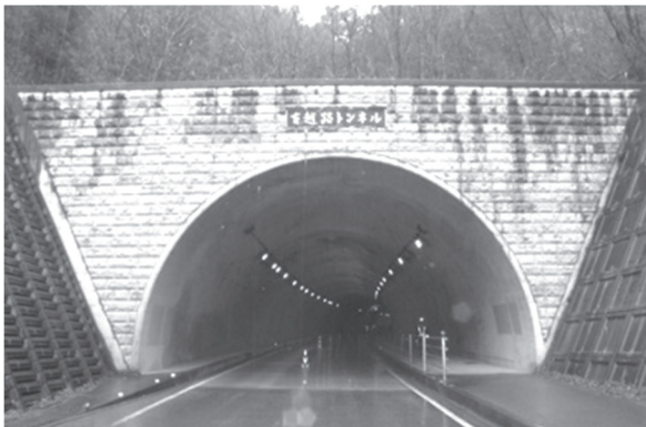
図2-6-82 古越路トンネル 葛生側坑口
