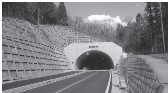
図 2-6-78 高瀬トンネル 宇都宮市側坑口
