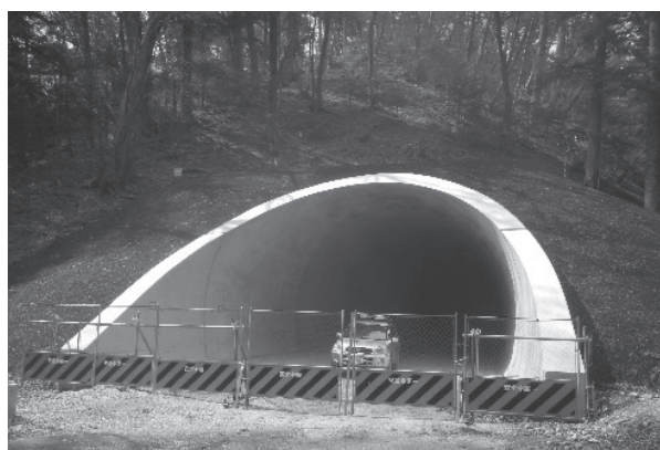
図2-6-72 下塩原第二トンネル 関谷側坑口
