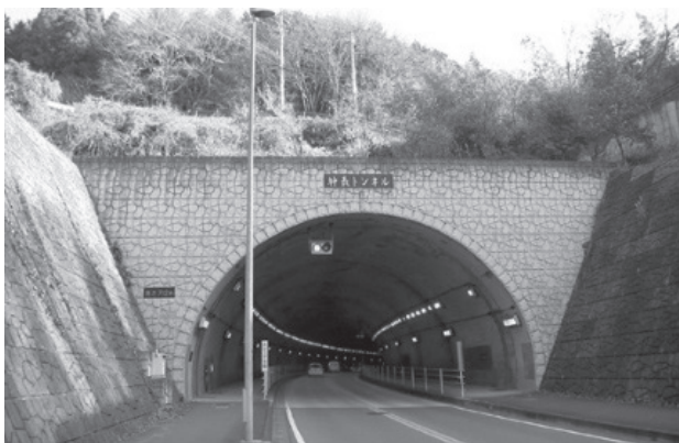
図2-6-76 神長トンネル 宇都宮側坑口
