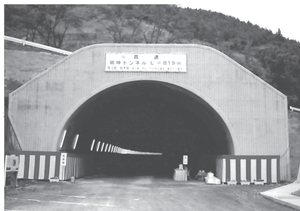
図2-6-73 明神トンネル貫通式（H10.10.6） （須佐木側坑口）
