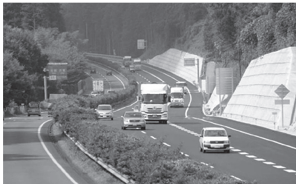
図2-10-2 延伸された矢板 IC 合流車線
