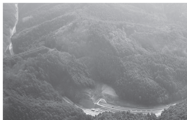
図 2-6-81 新会沢トンネル 佐野市側坑口
