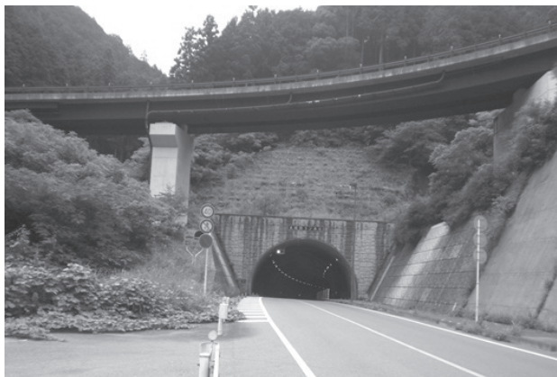
図2-6-61 大越路トンネル 粕尾側坑口
