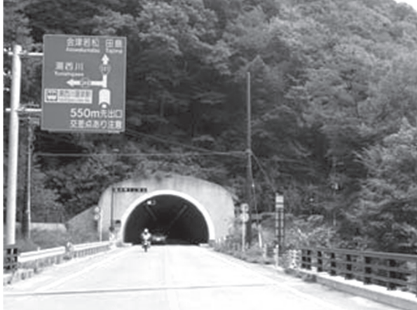
図2-6-63 湯の郷トンネル 川治側坑口
