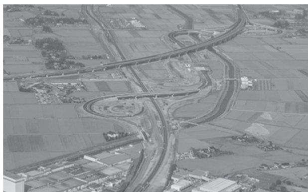
図 2 - 9 - 4 施工時の圏央道五霞 IC 及び 新4号国道春日部古河バイパス
