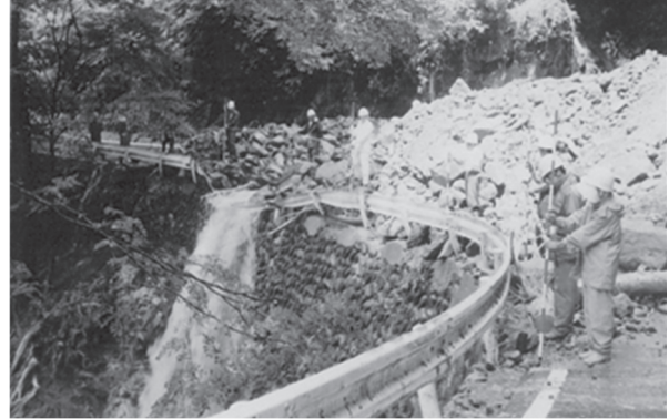
図2-6-70 平成10年 工区内現道
