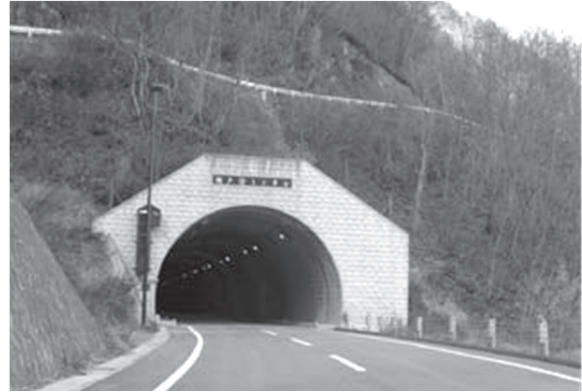
図2-6-64 瀬戸合トンネル 川治側坑口
