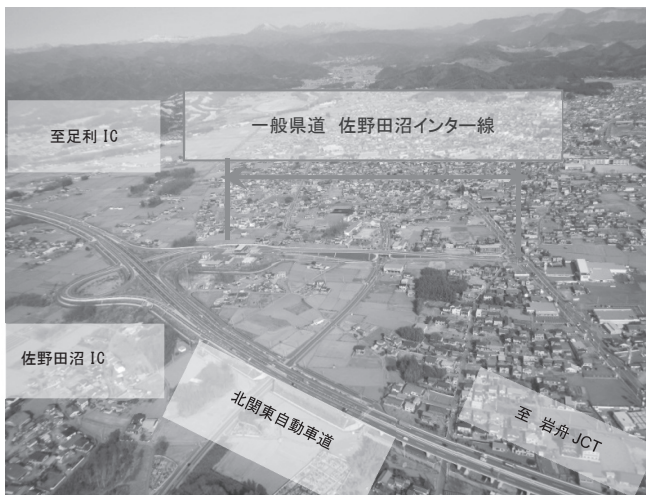
図 2-5-13 田沼インター工区
