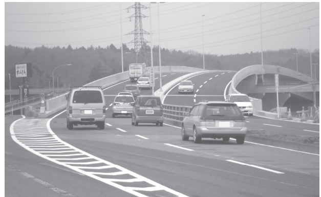
図 2-4-4 宮環・関堀陸橋 供用状況
