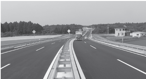
図2-4-26 真岡バイパス（真岡もめん大橋南）
