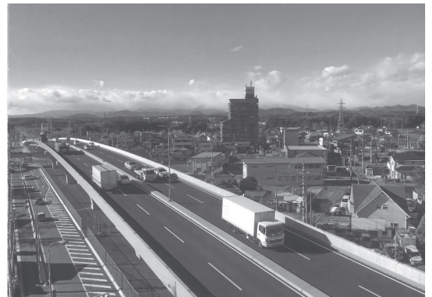
図 2-4-5 宮環・下川俣陸橋 供用状況
