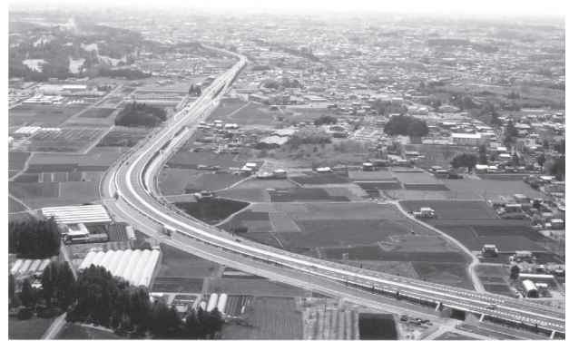
図 2-4-3 宇都宮北道路 供用状況
