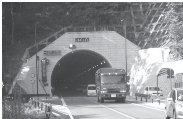
図2-4-25 下塩原バイパス（がま石トンネル）
