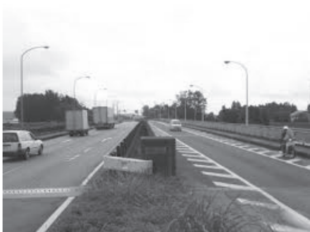
図2-4-19 鹿沼南バイパス（小倉橋）
