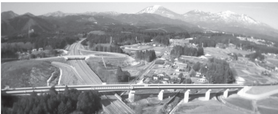
図2-4-13 板橋バイパス (土沢大橋)
