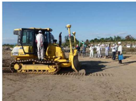
ICT-MC建機(ブルドーザ)の実践
