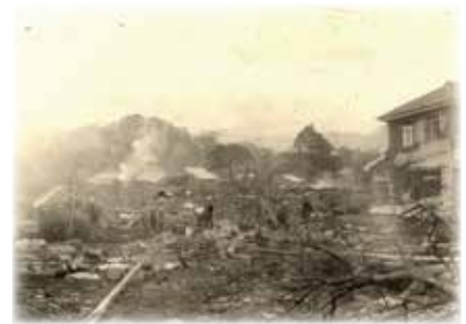
伊東海岸津波の跡
