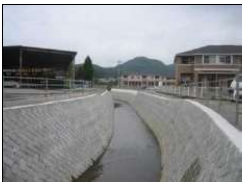
河川整備（小藪川 鹿沼市）
