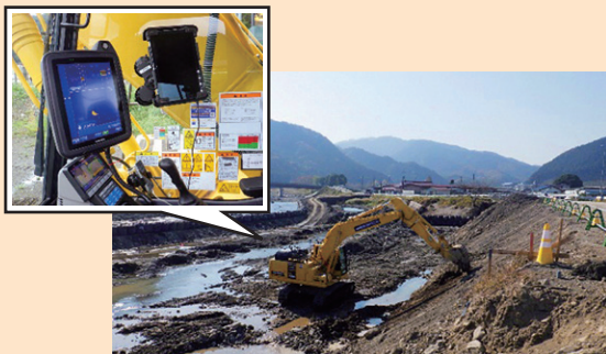
ICT建機施工（土工）
