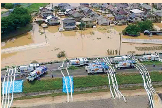
排水ポンプ車（出典：国土交通省資料）
