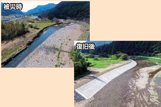
災害復旧状況 (彦間川/佐野市)
