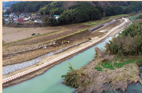
改良復旧状況 (荒川/那須烏山市)
