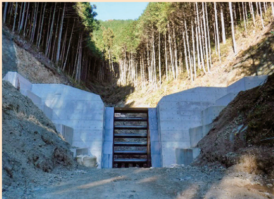
砂防施設の整備 (学校沢/鹿沼市)
