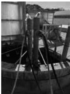
写真 1 曝気槽に設置した硫黄脱窒装置
