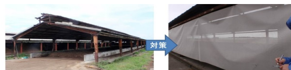
【対策前の堆肥化施設】
