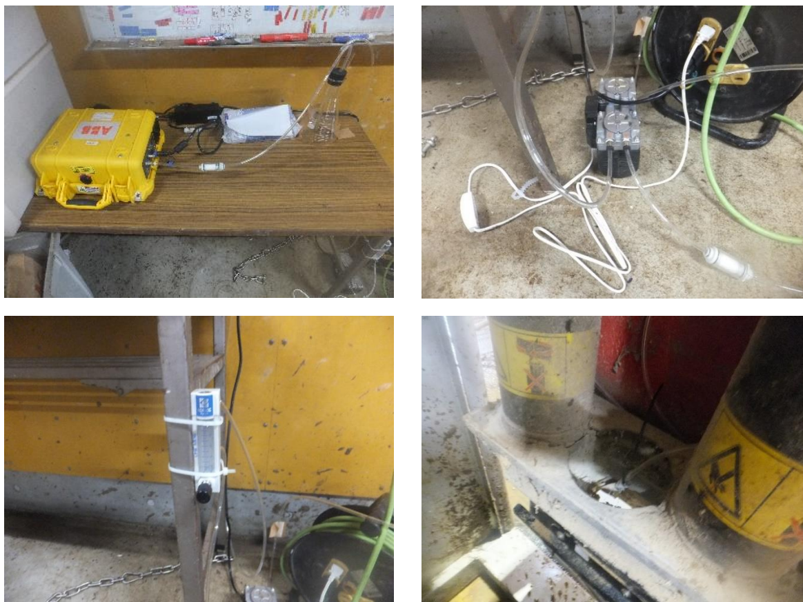
図 センターに設置したメタン測定機器
