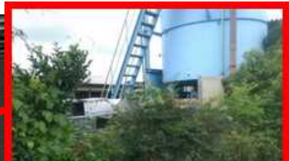
敷地外では臭気は低く、 内部では上昇する。
