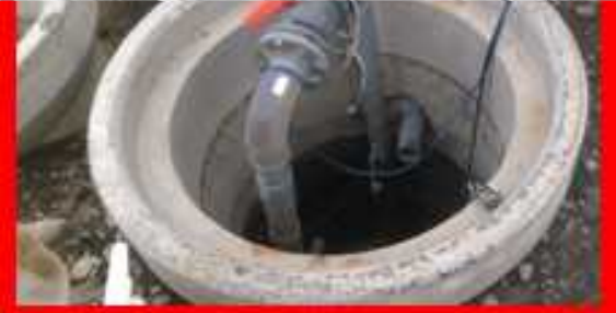
汚水の中継場所。 汚水が流入時に臭気は上昇。
