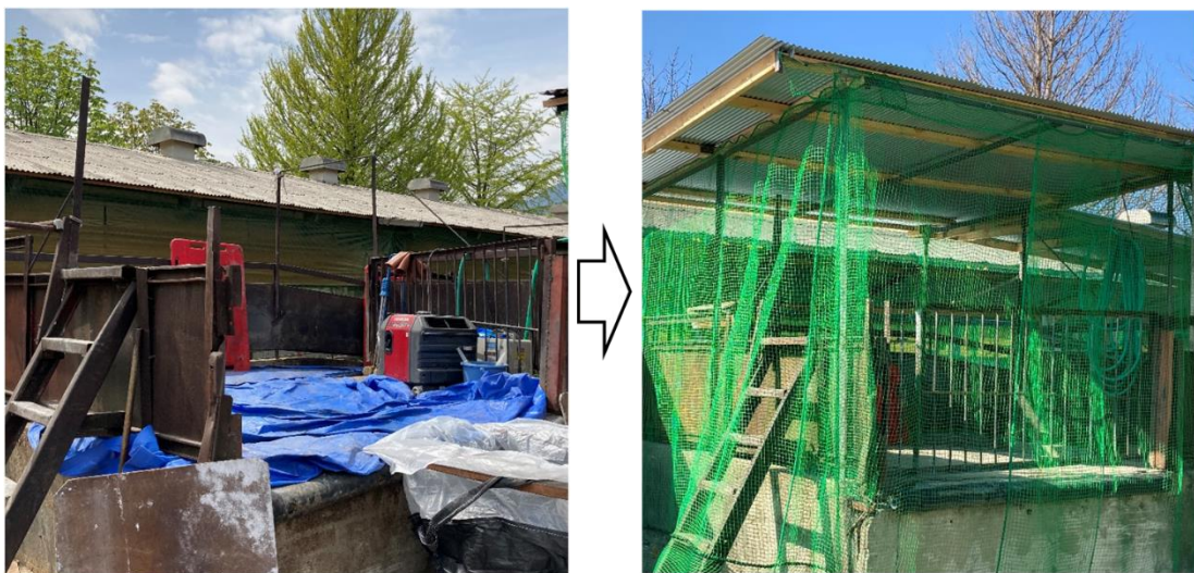
図 7 出荷台の改造・修繕
