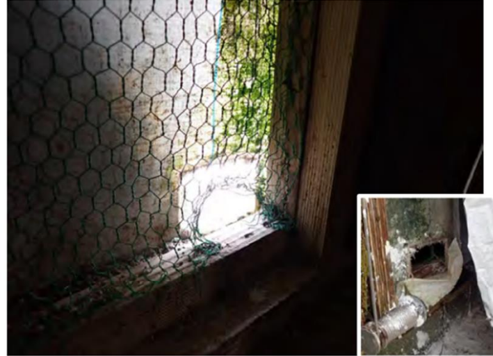
鶏舎の金網の破損部位。小動物が出入りした痕跡あり
