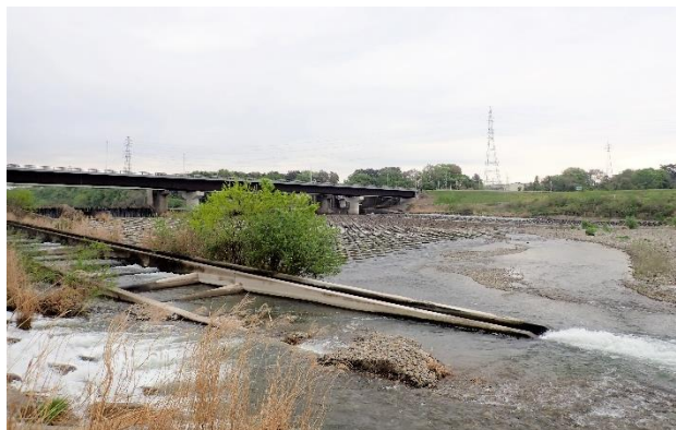
鬼怒川・勝瓜頭首工
