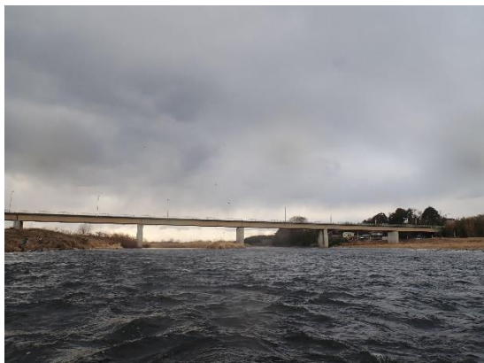
地点7 八溝大橋 下流
