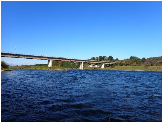
地点7 八溝大橋 下流
