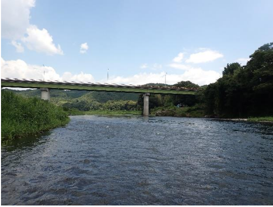
地点10 下野大橋下流
