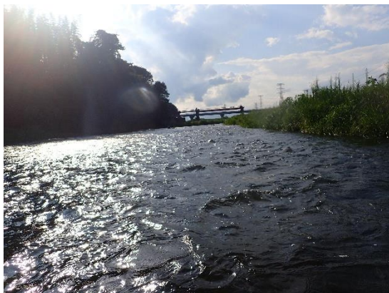
地点16 西の原頭 首工下流
