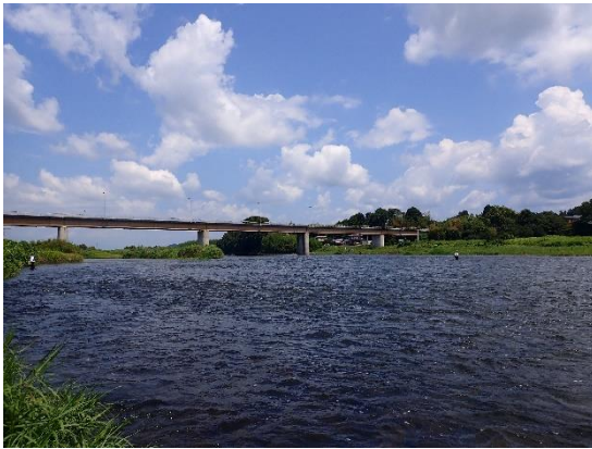
地点7 八溝大橋 下流
