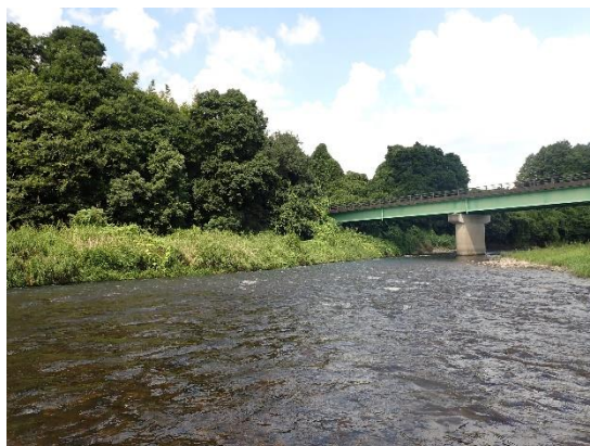
地点22 三箇橋上 流
