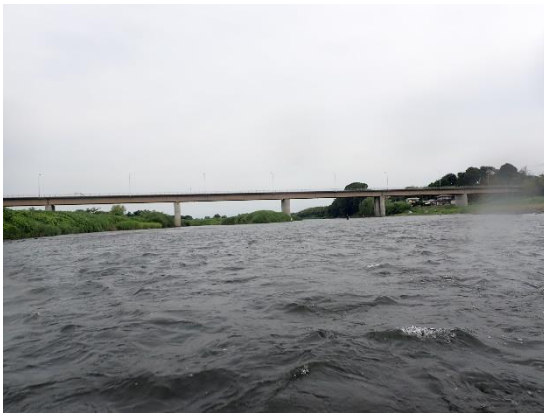
地点7 八溝大橋 下流
