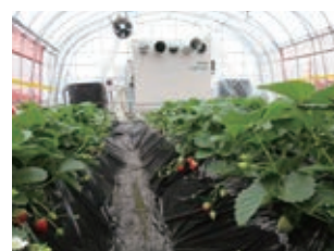
地下水熱源ヒートポンプ
