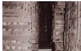
株冷蔵の入庫状況 昭和43年
