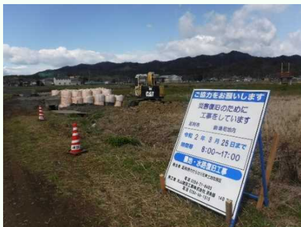
足利市駒場町 農地・水路復旧工事
