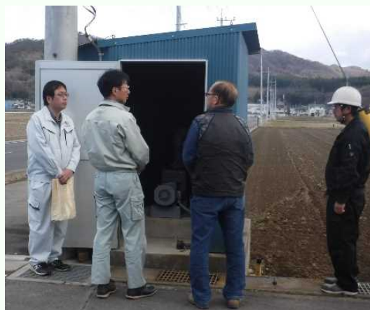
足利市迫間町 揚水機復旧工事
