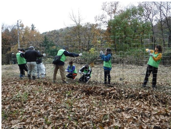
協働活動による侵入防止柵設置
