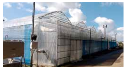
遊休化したハウスを移設、リノベーション ※産地生産基盤パワーアップ事業活用
