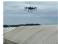
写真：ドローンを使った遮熱塗布剤散布
