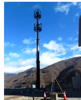
深山ダム：通信鉄塔建替工事
