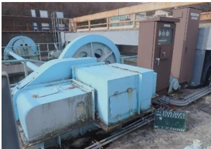
深山ダム：余水吐巻上装置点検修繕
