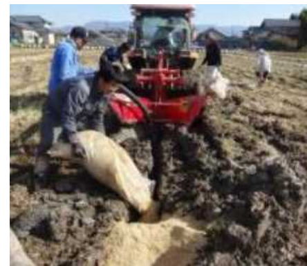
暗渠排水の整備
