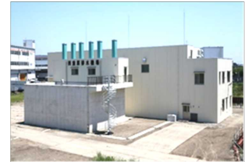
農業用排水機場の改修整備
