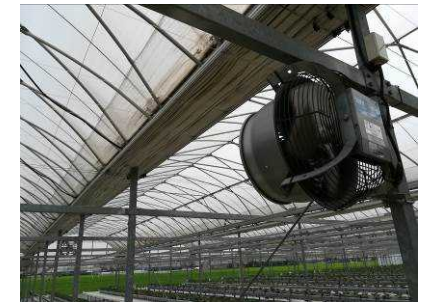
循環扇の設置
