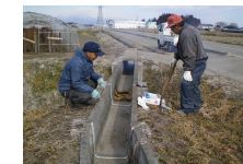
水路の簡易補修
