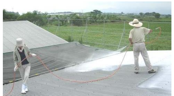
（屋根への石灰吹きつけ）
