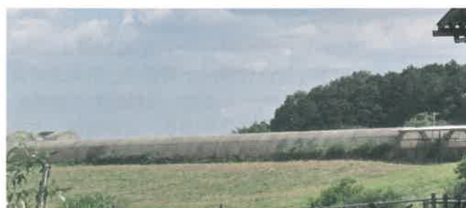
共同利用堆肥発酵処理施設
