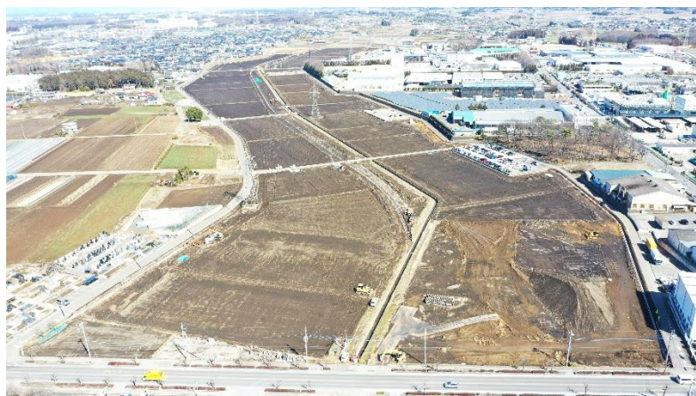
( 施工中ほ場の様子 )
