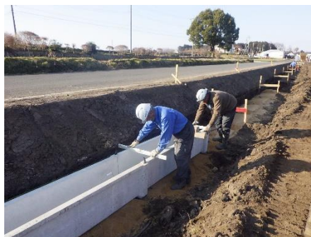
( 用水路を据え付ける様子 )
