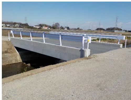
(農道橋の架け替えが完了)
