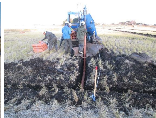
(暗渠排水工事の様子)
