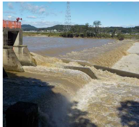
( 出水時の土砂吐、洪水吐ゲート )
