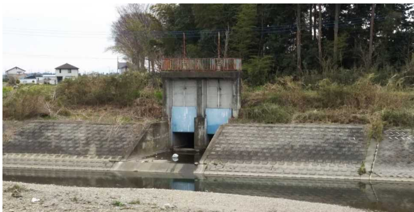
( 真弓地区の排水樋管・樋門 )
