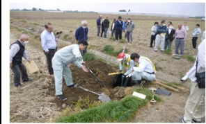
田んぼダム排水マスの設置
