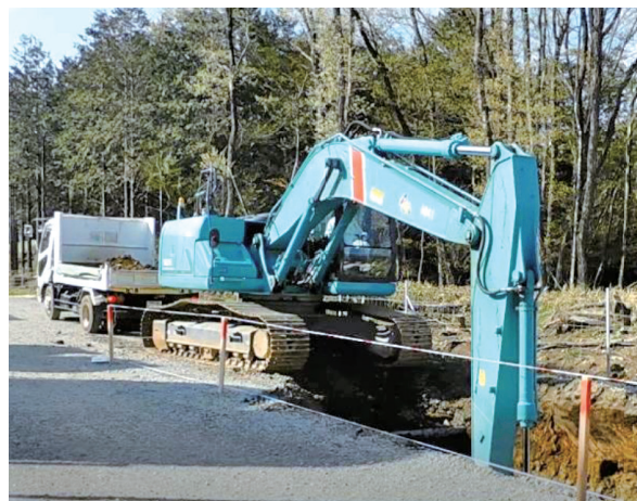
●埋却のための掘削作業●
