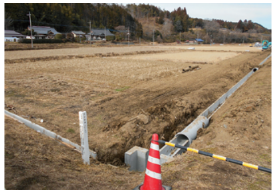
〔県営中山間地域総合整備事業（水路整備）〕
