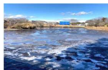
弁天下池(益子町)でのため池対策
