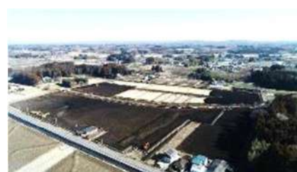
圃場整備工事の状況
