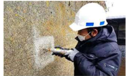
コンクリートの強度試験の様子
