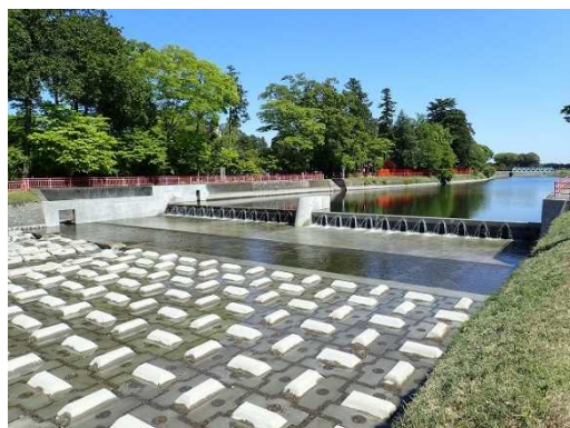
図4 令和の改修直後の大前堰
