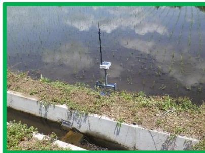
( 設置後の様子 )
