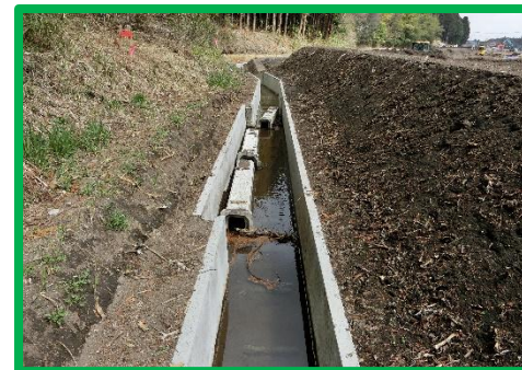
(環境配慮水路)
