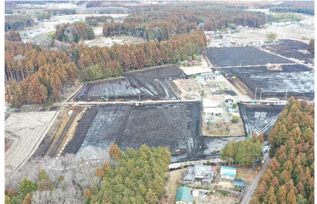
圃場整備施工中
