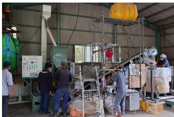
SGS 製造プラントの様子
