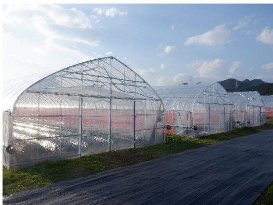
完成したパイプハウス
