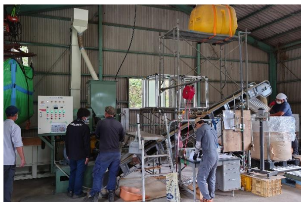
SGS 製造プラントの様子
