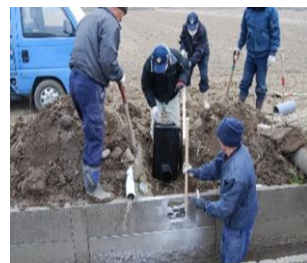
排水口の整備
