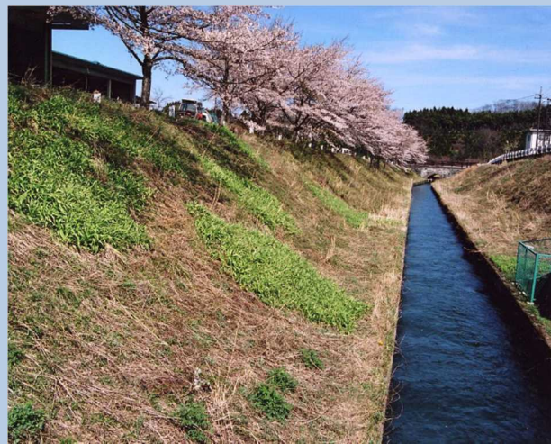
那須疏水幹線水路
