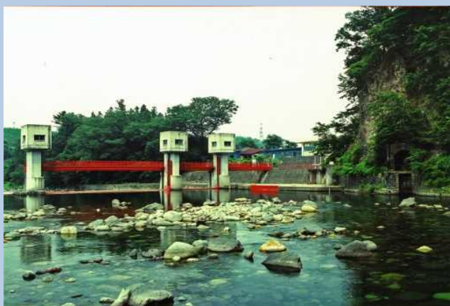
西岩崎頭首工
