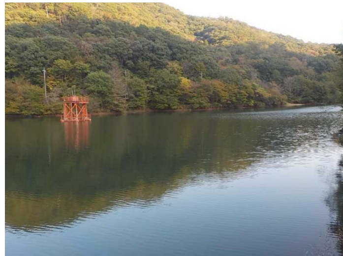
大郷戸ダム（昭和61年完了 県営かんがい排水事業）
