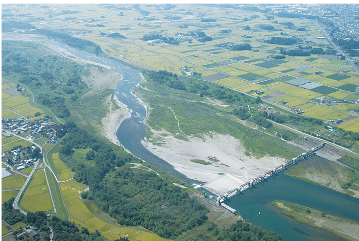
(写真) 岡本頭首工の上空から撮影。鬼怒川両岸は広大な水田地帯であり、岡本頭首工は水の安定供給という大きな役割を担っている。
