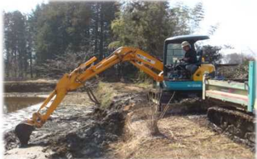
機械による浚渫
