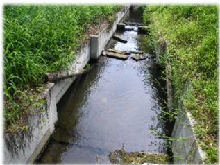
環境配慮水路工 （深み+拡幅）
