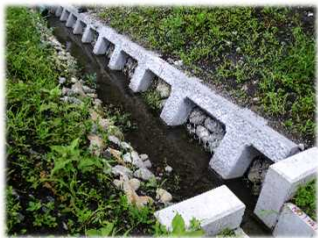
環境配慮護岸工 （湧水保全工）
