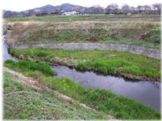
環境配慮水路工 （ワンド）
