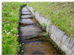
水路魚道工 （プール千鳥）
